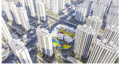
由中铁四局承建的成都高新发展总部项目，4780户居民的幸福生活。项目自开工以来，受到周边居民和开发商的广泛好评。
